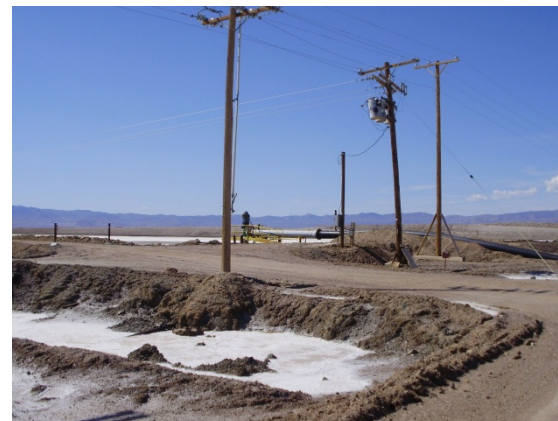
已有的电线及卡车运输基础设施
